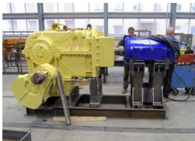
Montáž nového elektromotoru s převodovkou.
